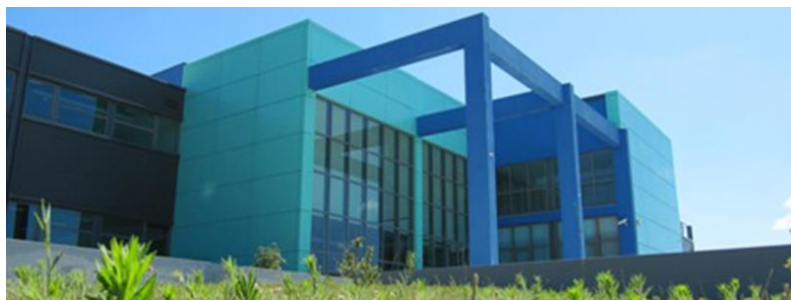
Figura 29. Instalações do CDRsp.
